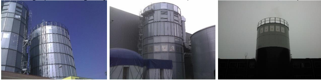
Voorbeelden van drukontlasting bij silo's
