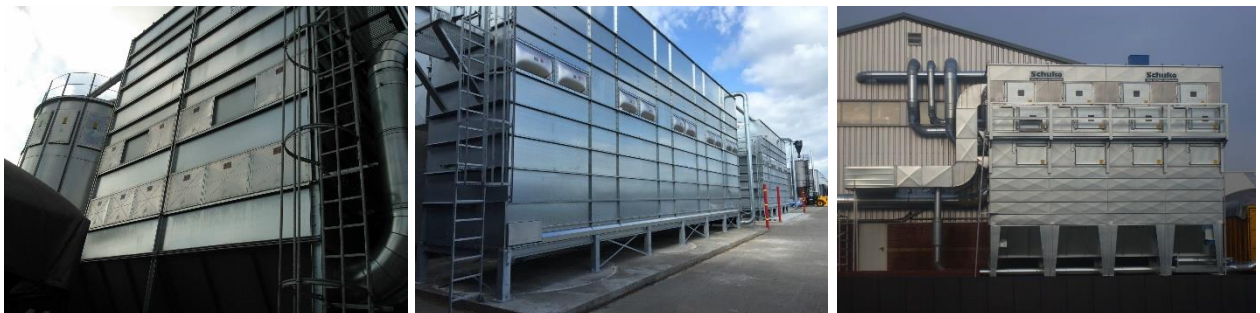
Voorbeelden van explosieluiken in filterinstallaties
