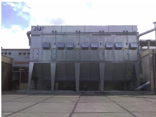
Voorbeelden van Filterinstallaties welke zijn voorzien van explosieluiken
